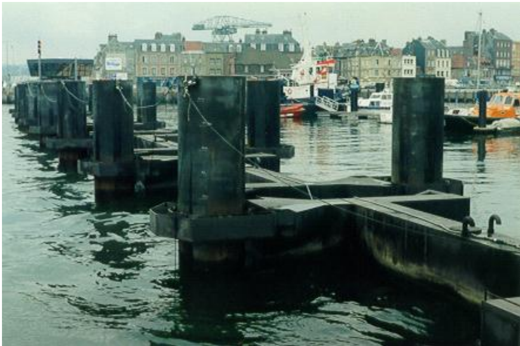
Figure 6.9 : Ligne d'atténuateurs ASB 5000 à Dieppe.
