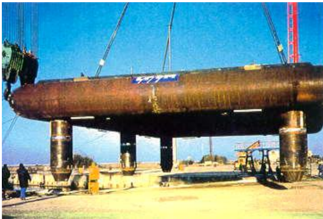
Figure 5.10 : Plaques de Barcelone en construction (Eiffel).
