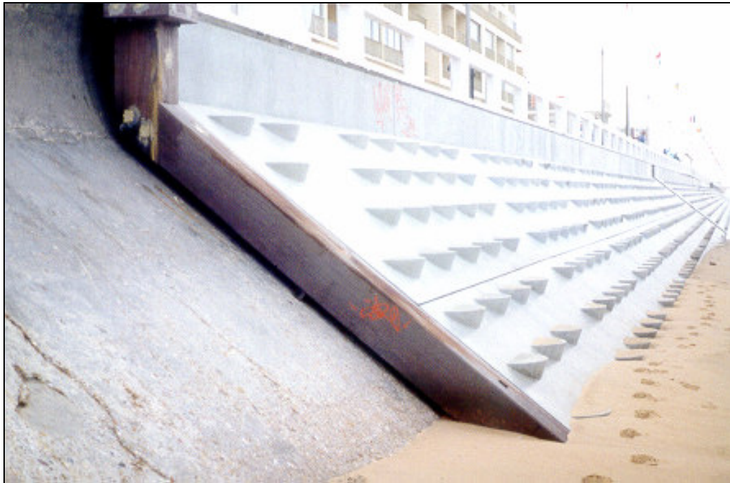
Figure 5.4 : Les Sables d'Olonne : recouvrement d'un ancien perré en béton par des éléments préfabriqués (photo J. Bougis).
