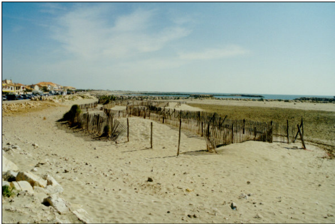
Figure 5.6 : Ganivelles installées aux Saintes Maries de la Mer pour tenter de reconstituer la dune (photo J. Bougis).
