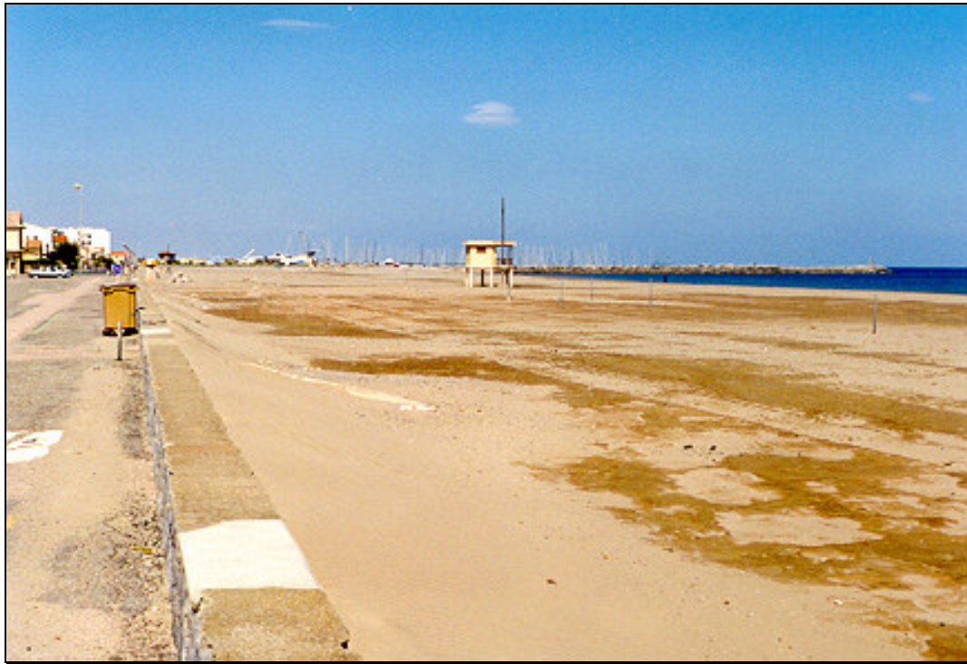
Figure 5.1 : Narbonne Plage, muret de haut de plage destiné à cantonner le sable côté plage (photo J. Bougis).
