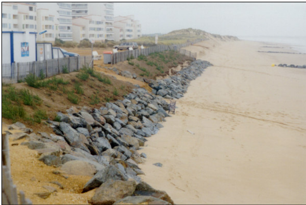
Figure 5.5 : Saint Hilaire de Riez : enrochements de haut de plage disposés à même le sol (photo J. Bougis).
